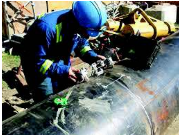
Figura 1.12. Medición del espesor de una tubería en operación. (Fuente: https://consumerenergyalliance.org ).
