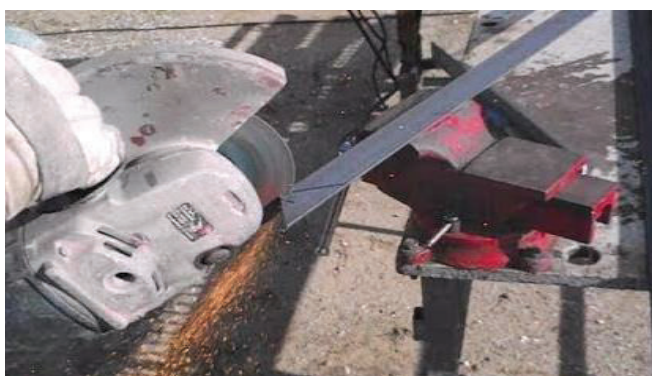
Figura 11. Corte por abrasión de los ángulos metálicos Elaboración: Propia.
