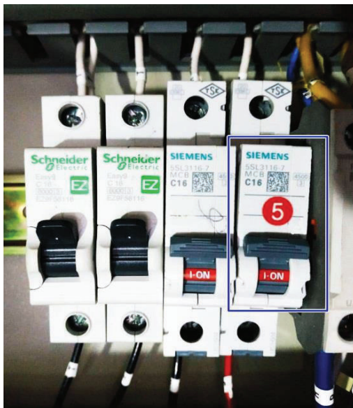
Figura 5. Interruptor magnetotérmico unipolar de 16 (A) Elaboración: Propia.
