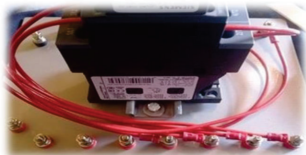
Figura 21. Montaje de los contactores en las placas móviles (vista posterior). Elaboración: Propia.
