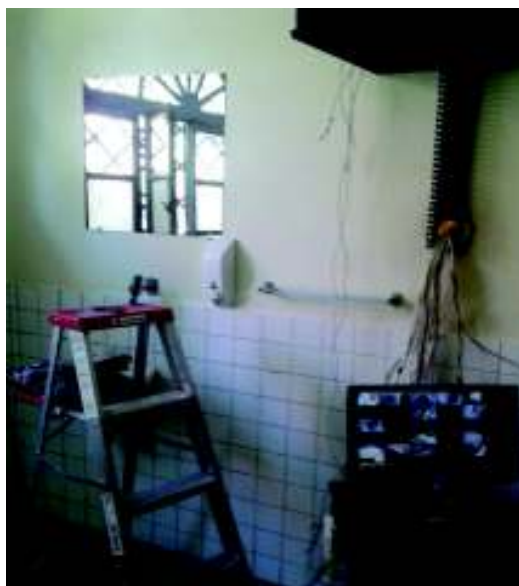
Figura 44: Pruebas de enfoque de cada cámara instalada.
