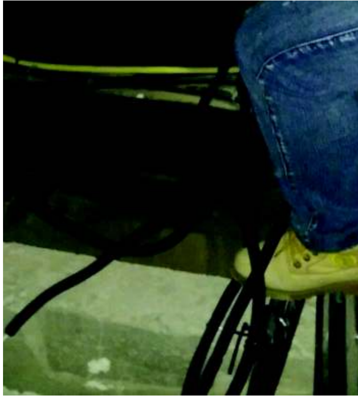
Figura 33: Pase de manguera corrugada en techo de aulas.
