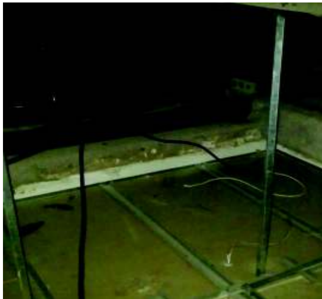
Figura 35: Pase de cable UTP manguera corrugada ala norte.
