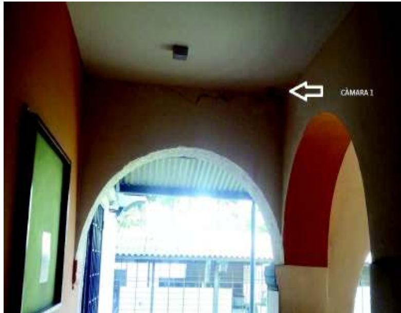
Figura 17: Cámara instalada aula 21
