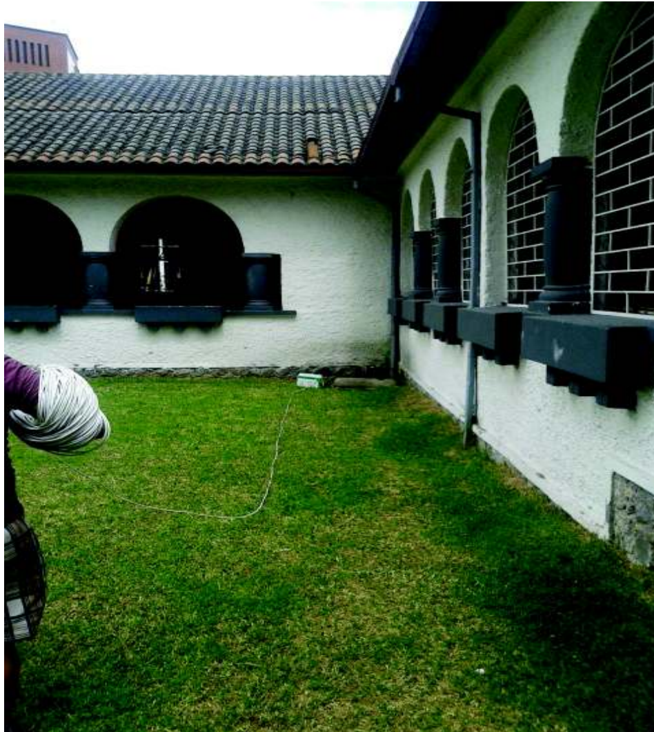
Figura 25: Medición de cable UTP a usar en el tramo cámara-cuarto de equipos.
