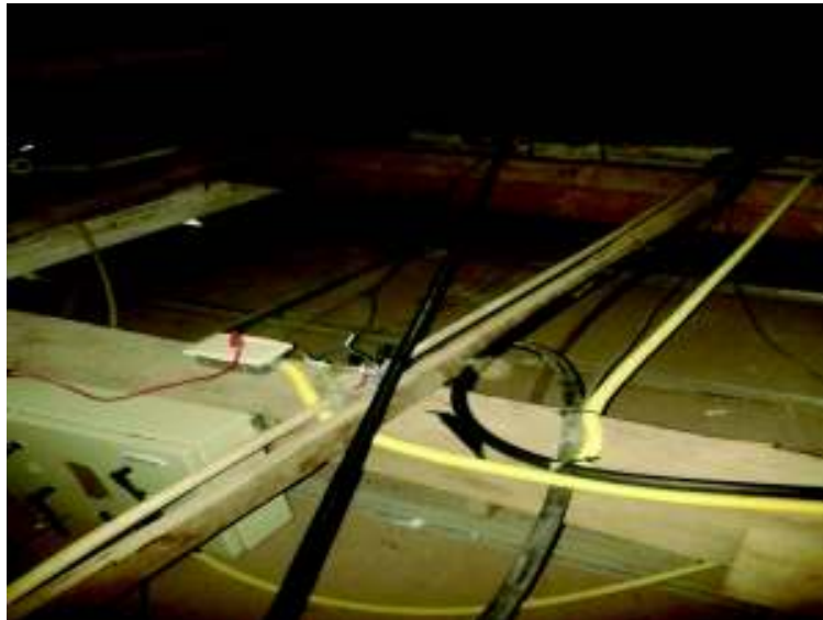
Figura 21: Cubierta de aulas ESFOT 2.
