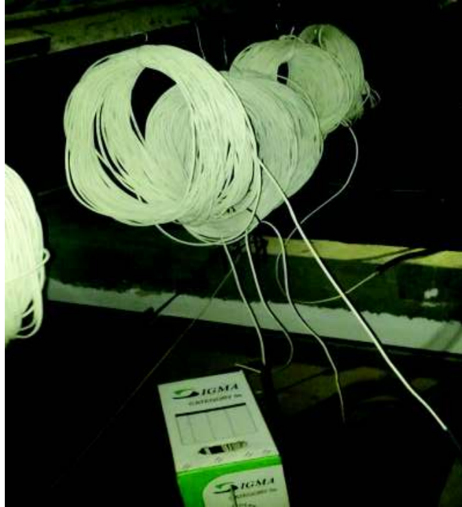
Figura 34: Pase cable UTP en manguera corrugada.
