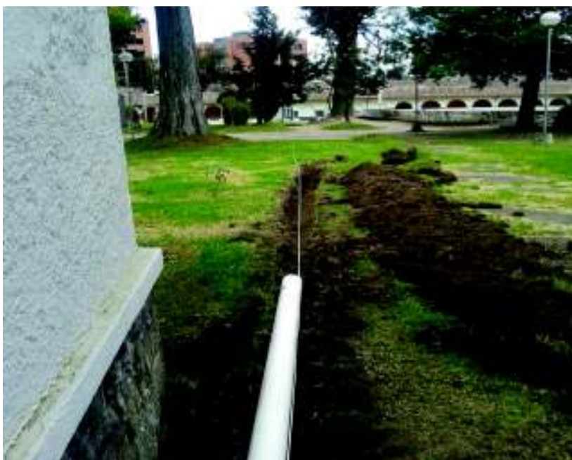
Figura 23: Implementación de zanja desde dirección hacia aulas de la ESFOT.
