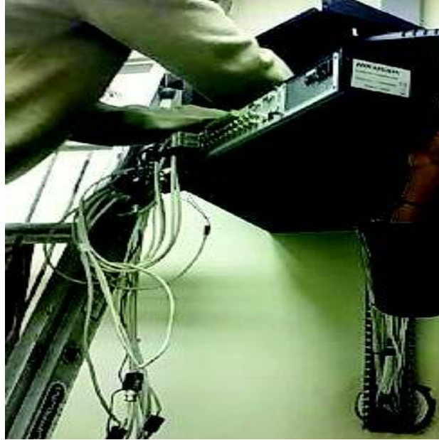
Figura 39: Instalación de DVR en Rack.
