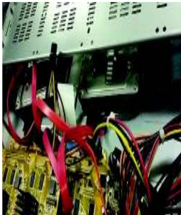
Figura 40: Instalación del disco duro en DVR.
