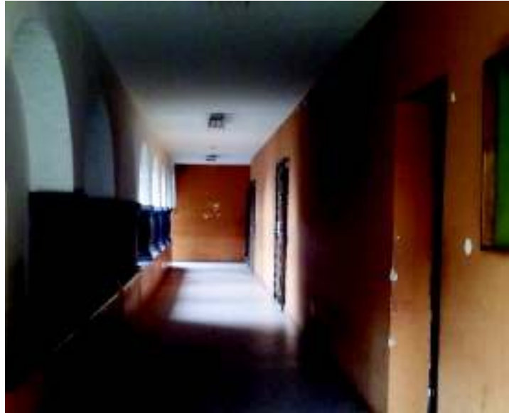
Figura 16: Pasillo aula 21 vista (este-oeste).
