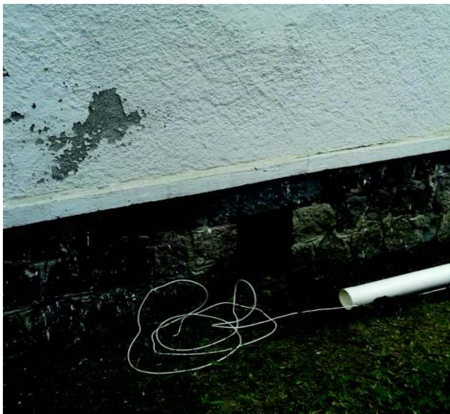
Figura 24: Culminación de zanja para acceder al cuarto de equipos.
