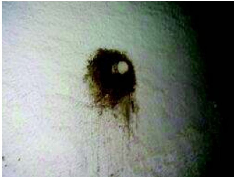
Figura 28: Tubería de ingreso a cuarto de equipos.
