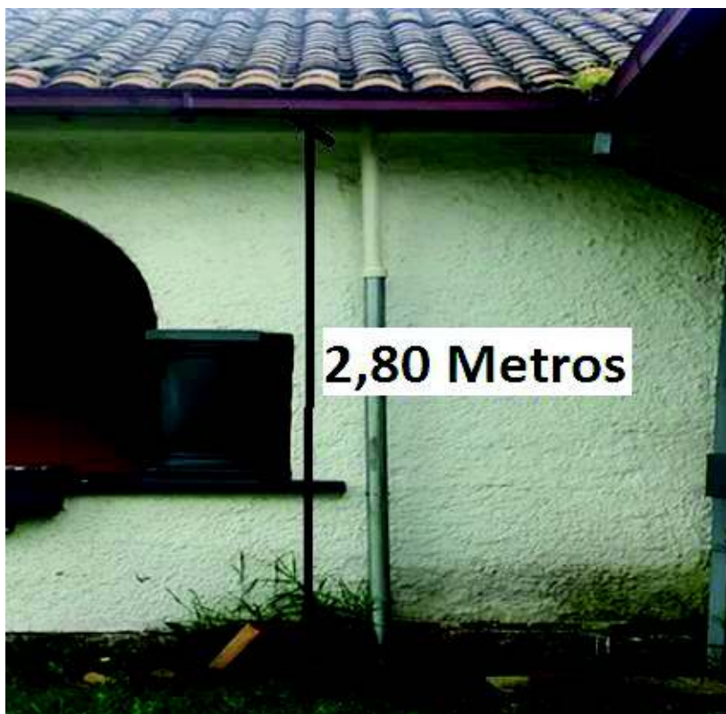
Figura 26: Ducto de acceso cable UTP (zanja-tumbado ESFOT).
