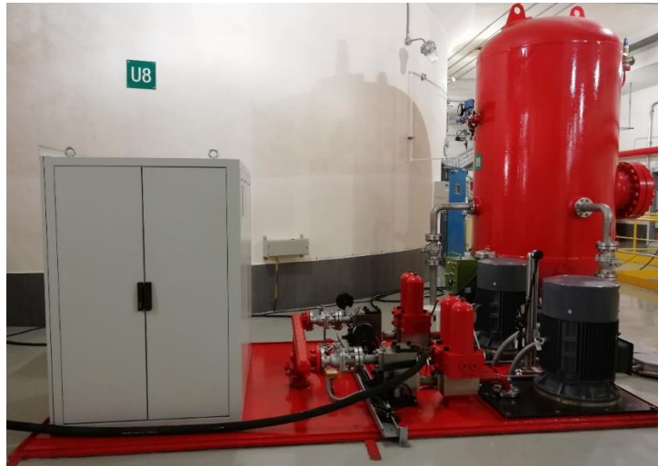
Figura 1.8. Componentes del sistema del regulador de velocidad
