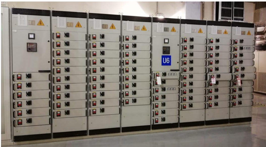
Figura 3.17. Sistema del regulador de velocidad (derecha 480 V e izquierda 220 V)
