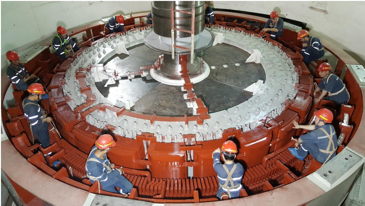
Figura 2.5. Estructura rotor y estator acoplados
