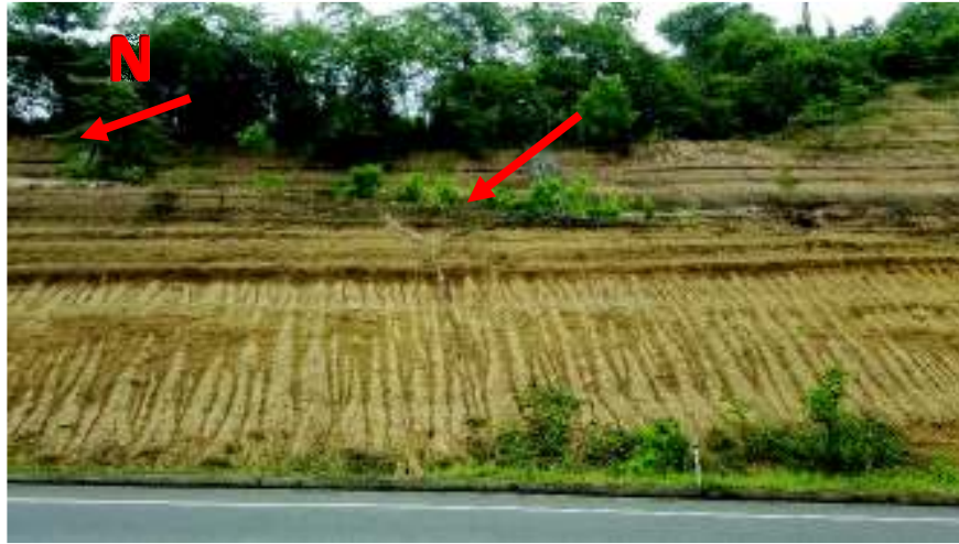
Figura 4.31. Fracturas rellenas de carbonato que cortan verticalmente las facies de limos masivas.
