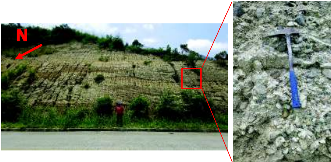
Figura 4.9. Canales fluviales en el corte de la carretera Jama-Canoa.
