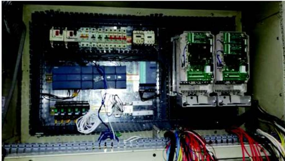
Figura 18.-Disposición de los elementos en el interior del tablero
