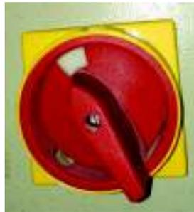
Figura 14.- Interruptor general tablero de control.
