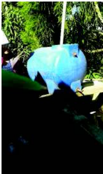
FIGURA 16: TANQUE PARA LA RECOLECCIÓN DE AGUA LLUVIA
