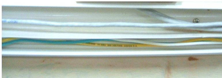
FIGURA 2.5: UBICACIÓN DE CABLES EN LA CANALETA
