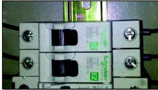
Figura 42: Breaker de 16 Amperios para circuitos de tomacorrientes
