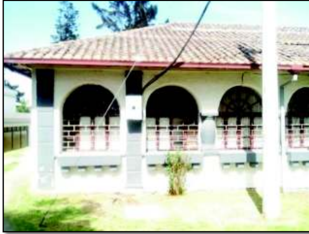
Figura 24: Alimentación 2, ubicada en parte posterior de oficina 28
