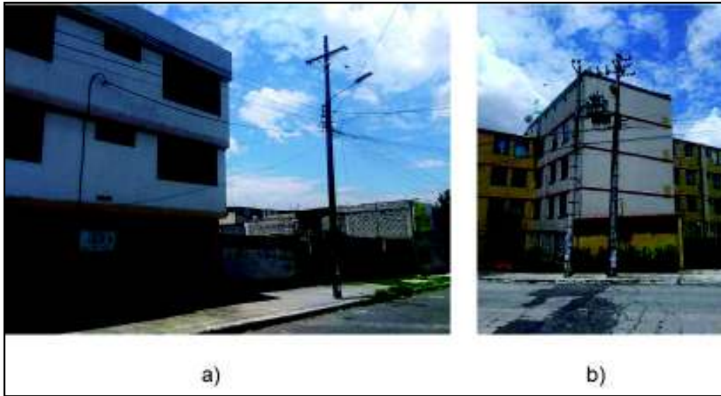
Figura 4: (a) Acometida aérea, (b) Acometida subterránea
