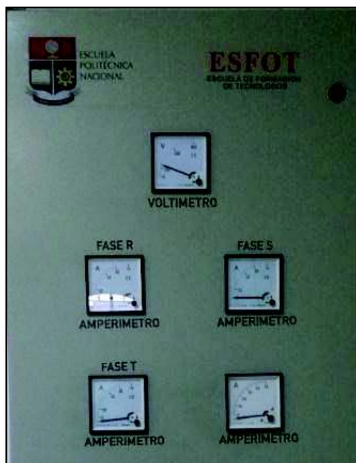
Figura 49: Disposición de Instrumentos de Medición
