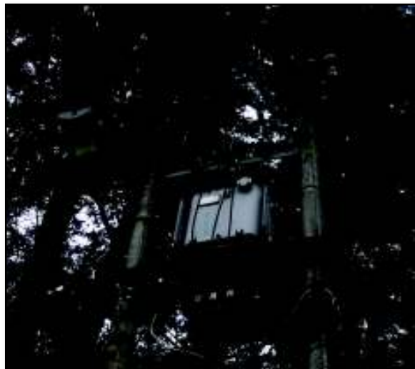
Figura 20: Transformador perteneciente a la EEQ.
