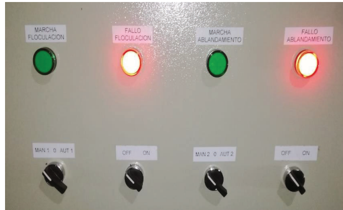
Figura 22. Simulación de fallos de las bombas
