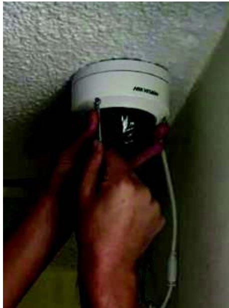
Figura D. 5 Limpieza de polvo a la cámara.
