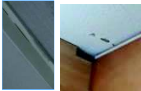
Infraestructura de ruteo
