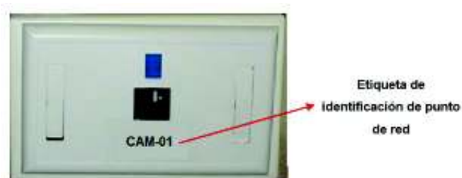
Figura 3. 9 Etiquetado de punto de red
