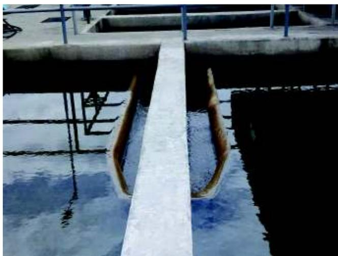
*Figura 30: Canal de agua sedimentada*
