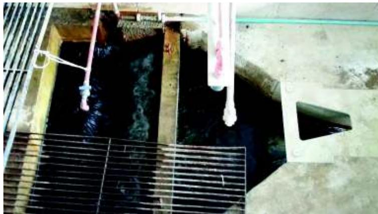
*Figura 27: Canal de flujo crítico de superficie libre Khafagi-venturi y cámara de mezcla rápida*
