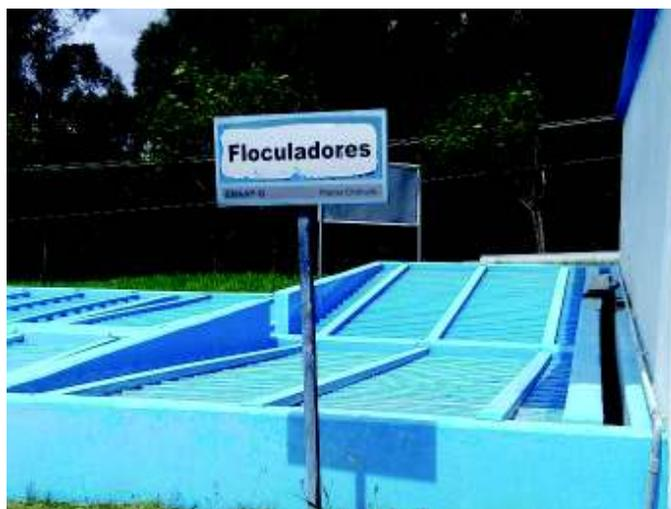
*Figura 28: Unidades de floculación hidráulica de flujo horizontal*
