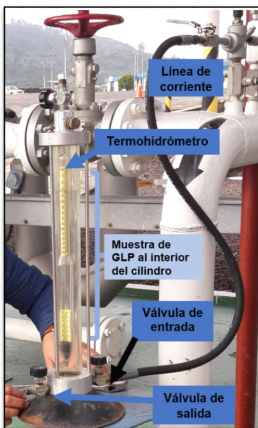
Figura 2.3. Termohidrómetro para la determinación de la densidad relativa del GLP
