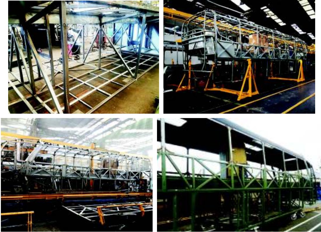
Figura 3.45. Inspección in situ, estructura importada. (Fuente: Propia, 2018)
