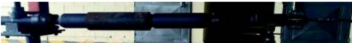
Figura 4.30 Colocación del casing Fuente: Andrade Ismael, 2018
