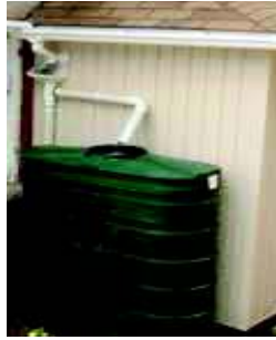
Figura 1.18. Tanque de plástico a ras de piso. Fuente: [20]
