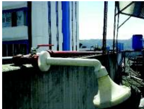
Figura 2.39. Construcción del subsistema de distribución.
