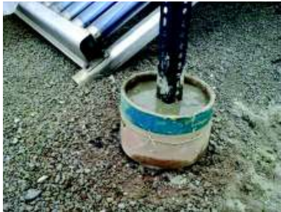
Figura 2.28. Plinto de concreto.
