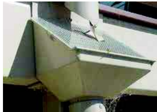
Figura 1.34. Apertura y malla para filtración de sólidos. Fuente: [20]
