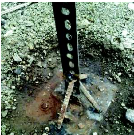
Figura 2.26. Base de la estructura.
