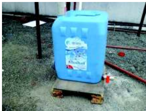
Figura 2.38. Tanque de primeras lluvias, entrada de agua contaminada, toma de agua no sanitaria y tapón de mantenimiento.
