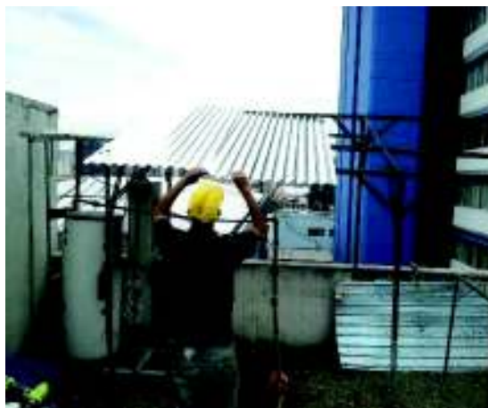
Figura 2.29. Construcción de la superficie de captación prototipo (A).
