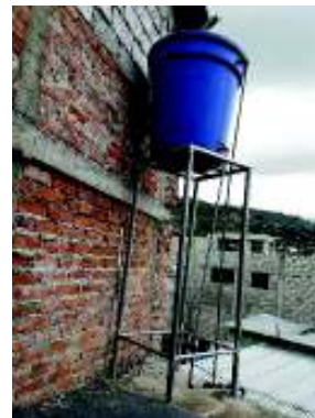
Figura 1.21. Tanque de agua para viviendas unifamiliares a un nivel superior al ras de piso.
