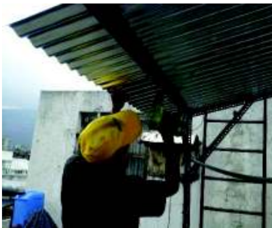
Figura 2.30. Construcción de la superficie de captación prototipo (B).
