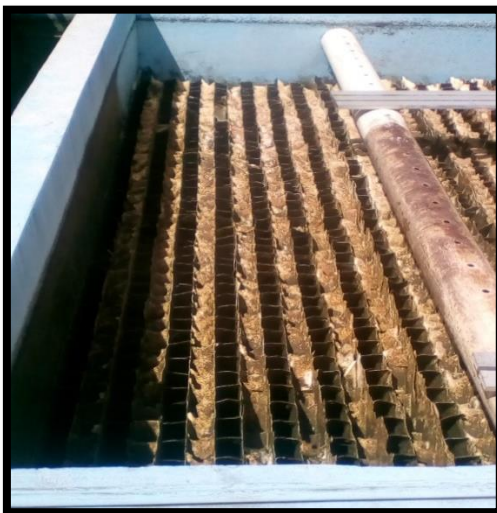
Figura 5.6 Seditubos deteriorados
