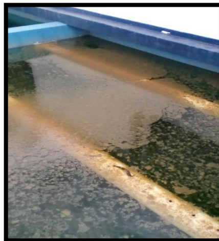
Figura 5.5 Formación de película de lodo
