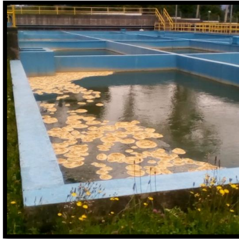
Figura 5.4 Formación de espumas de sulfato
