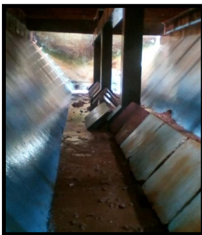
Figura 5.7 Lodos retenidos en el fondo del sedimentador
