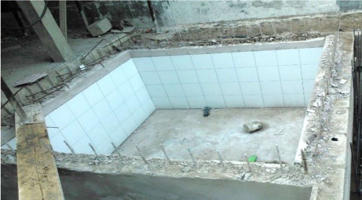
Figura 3.25. Construcción y delimitación de cisterna Fuente: Propia en domicilio
