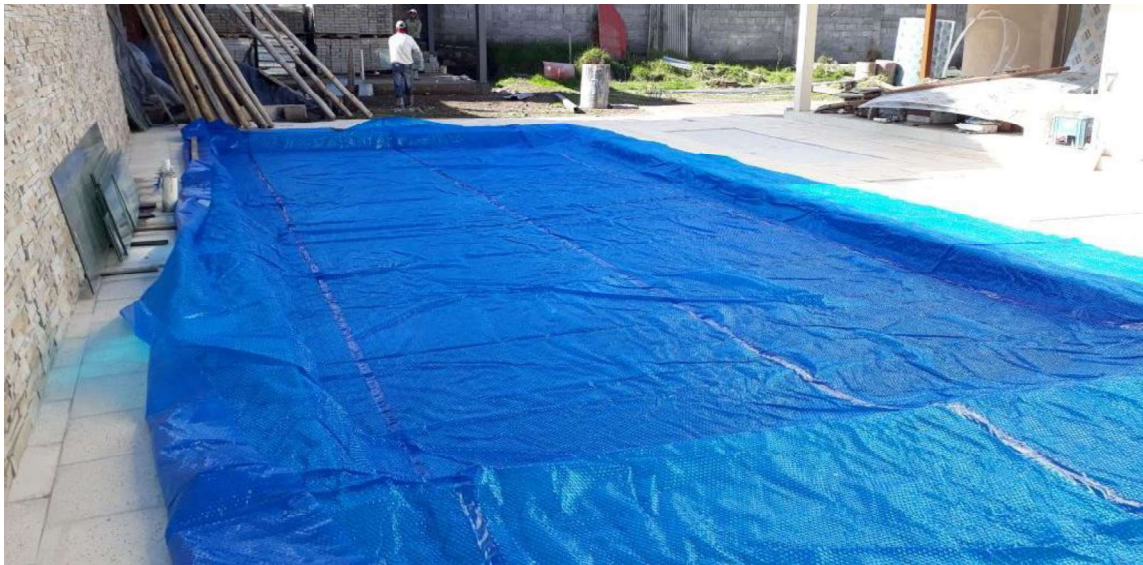
Figura 3.59. Recubrimiento manta térmica
