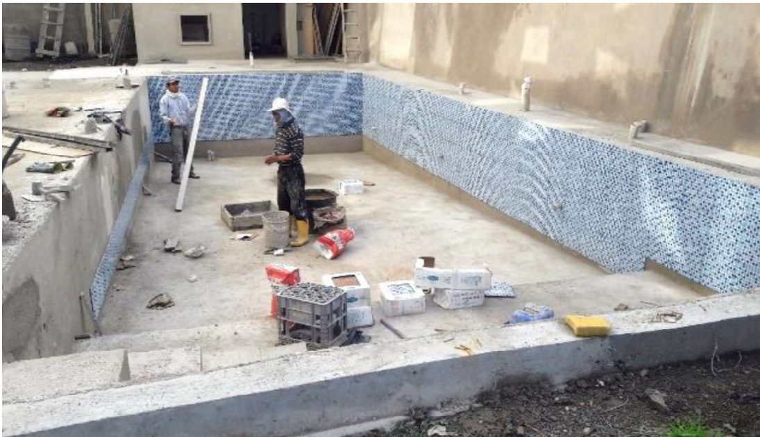
Figura 3.40. Pegado de baldosa en la base de hormigón Fuente: Propia en domicilio
