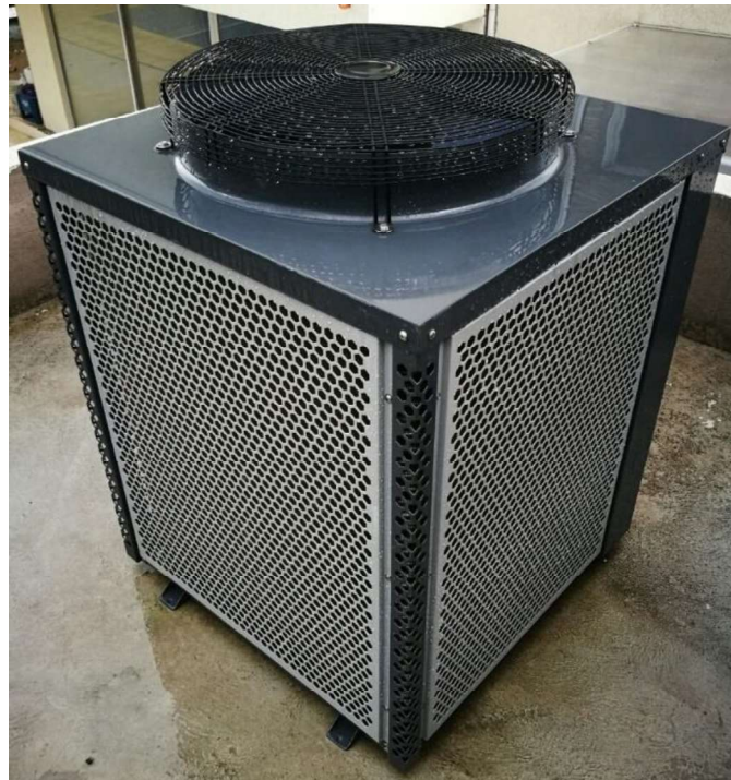
Figura 3.50. Bomba de calor a instalarse Fuente: Propia en domicilio
