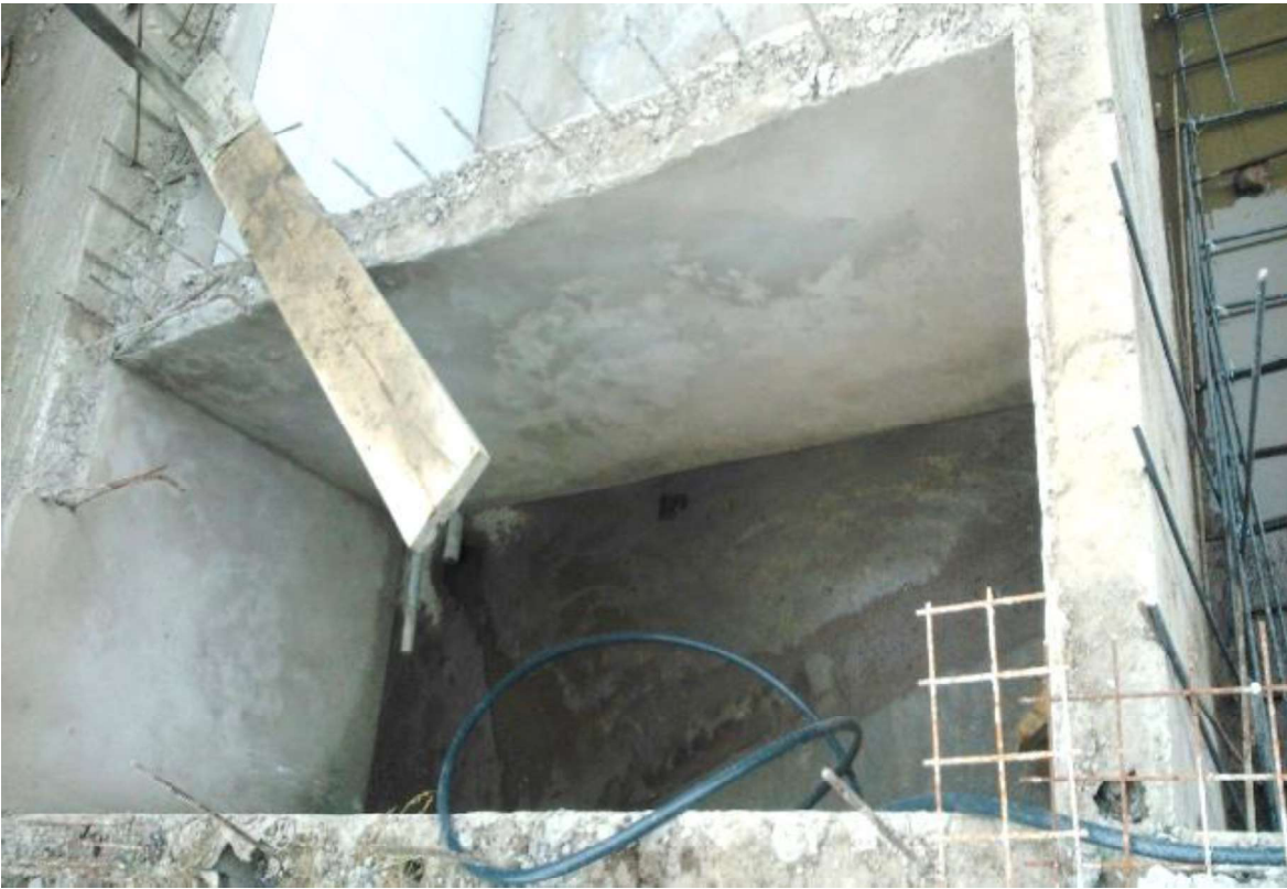
Figura 3.26. Construcción y delimitación del cuarto de máquinas Fuente: Propia en domicilio
