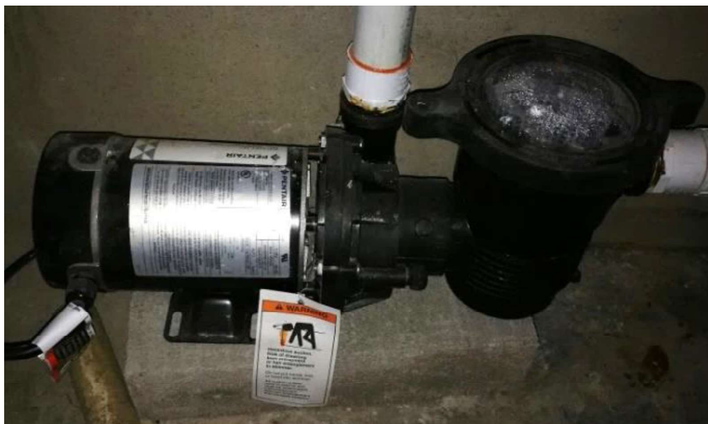
Figura 3.38. Bomba marca Pentair 1 HP Circuito Secundario Fuente: Propia en domicilio
