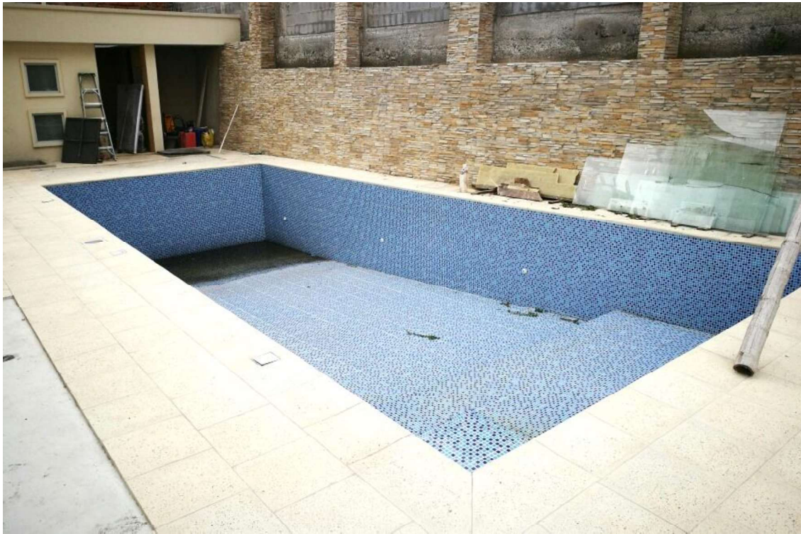
Figura 3.27. Fundición total de piscina
