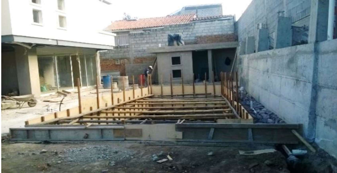
Figura 3.39. Apuntalado previo a la fundición con hormigón Fuente: Propia en domicilio
