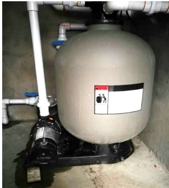
Figura 3.62. Instalación del filtro de la piscina Fuente: Propia en domicilio
