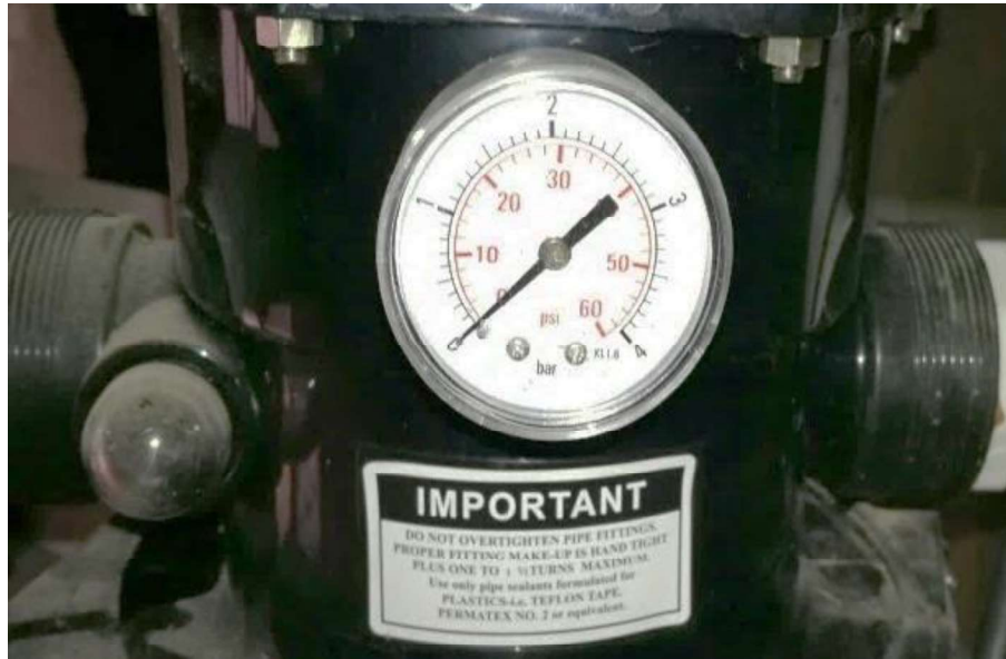
Figura 3.34. Manómetro e indicador de flujo del filtro Fuente: Propia en domicilio
