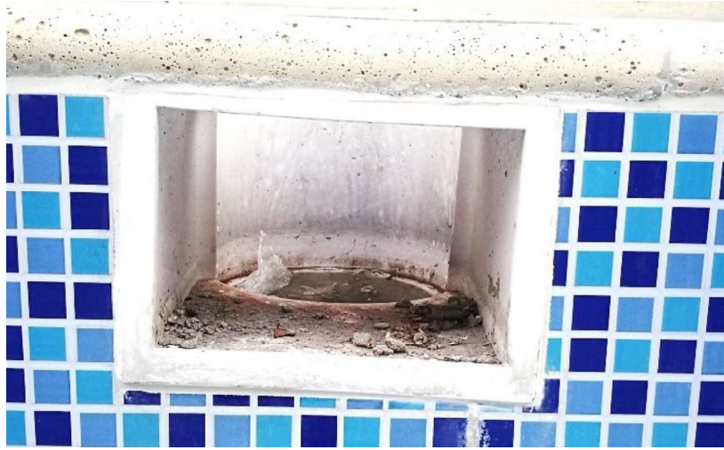
Figura 3.43. Instalación final de Skimmer Fuente: Propia en domicilio
