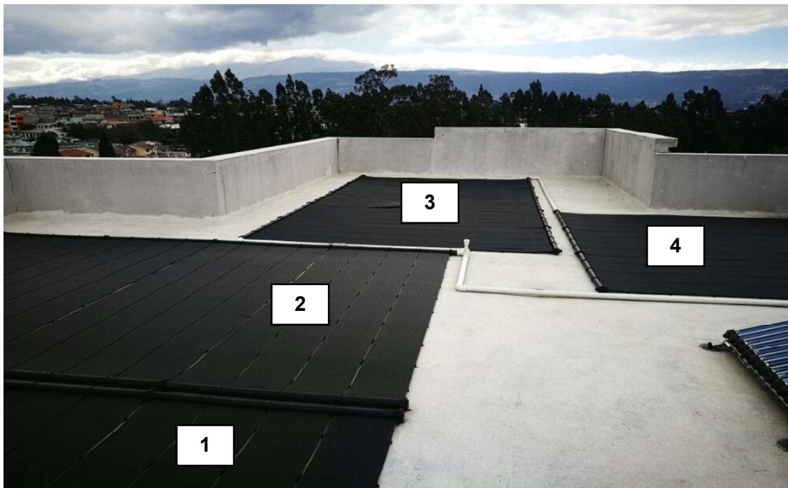
Figura 3.48. Instalación de baterías en serie y paralelo Fuente: Propia en domicilio
