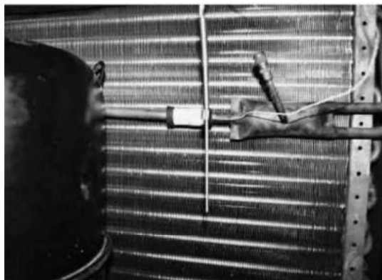
Figura 6.5. Condensador de la bomba de calor Fuente: Martínez, F. J. R., & Gómez, E. V, 2005
