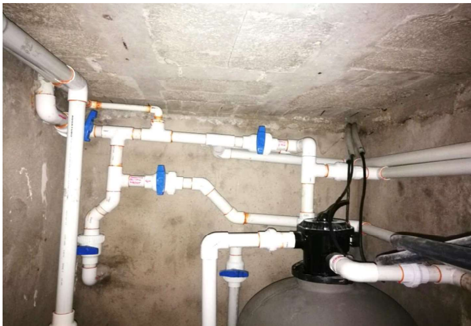
Figura 3.32. Instalación de tuberías desde y hacia la piscina dentro del cuarto de máquinas Fuente: Propia en domicilio
