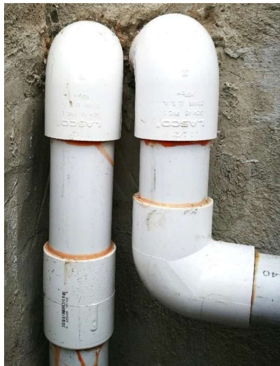
Figura 3.74. Verificación de fugas en juntas y codos Fuente: Fuente Propia
