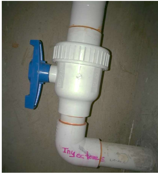
Figura 3.75. Verificación de fugas en válvulas de bola Fuente: Fuente Propia
