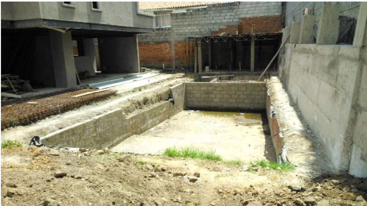
Figura 3.24. Excavación y delimitación de piscina Fuente: Propia en domicilio
