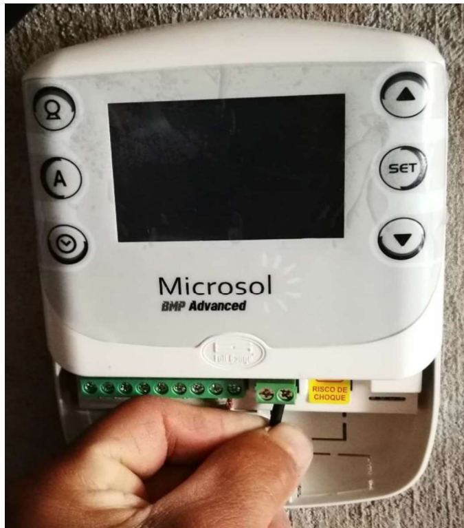
Figura 3.53. Instalación del cableado y energización del controlador Fuente: Propia en domicilio
