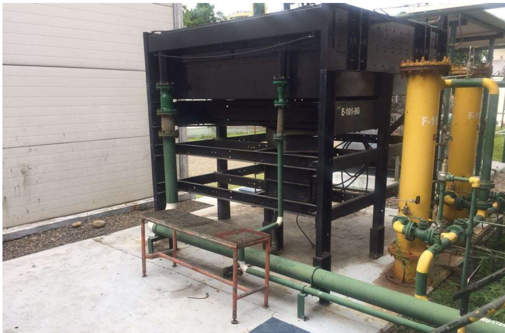
Figura 2.12. Aero enfriador para disipación de calor de agua de camisas.
