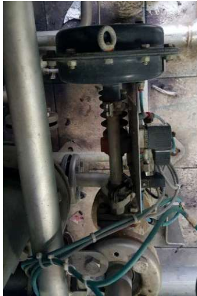
Figura 2.24. Regulador de presión Sleildruck. (Fuente: Autores)
