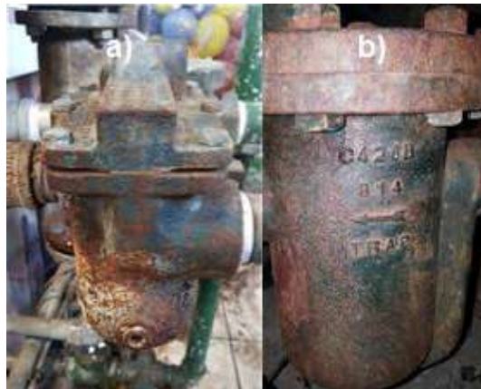
Figura 2.25. Trampas de vapor: a) Trampa de vapor tipo flotador, b) Trampa de vapor tipo balde invertido.
