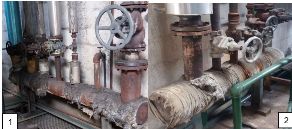
Figura 2.8. Distribuidor de vapor 1 (izquierda), y 2 (derecha) (Fuente: Autores)
