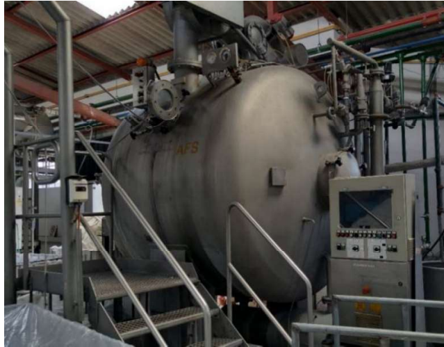
Figura 2.17. Máquina de tinturación Nº 8. THEN. (Fuente: Autores)
