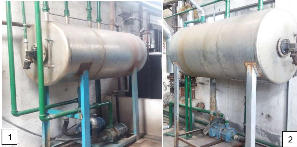
Figura 2.10. Tanque de condensado 1 (izquierda), 2 (derecha) (Fuente: Autores)
