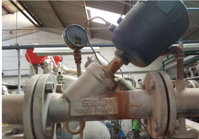
Figura 2.23. Regulador de presión Burkert. (Fuente: Autores)
