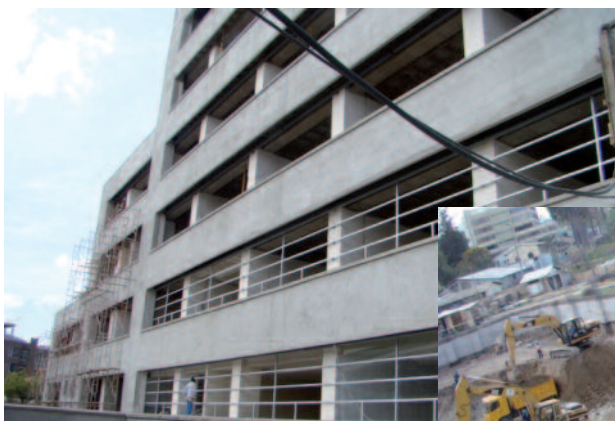
Vista parcial del edificio de Aulas y Relación con el Medio Externo
