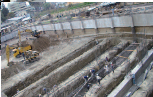
Avance de los trabajos de la Segunda etapa
