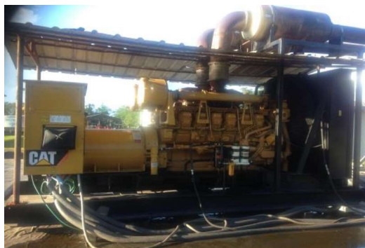
Figura 1.3. Grupo Electrónico propio del Bloque 60 (CAT 3512) (Fuente: Diego Garcés (fotógrafo), al 15 de diciembre del 2016)
