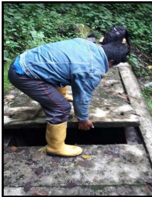
Figura 30. Tanque de almacenamiento Peña Blanca FUENTE: (El Autor,2018)
