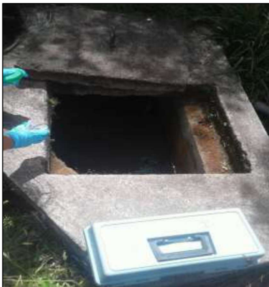
Figura 19 Captación Vertiente desemboca Río Chacpito
