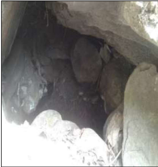
Figura 16 Captación Quebrada Coricolima
