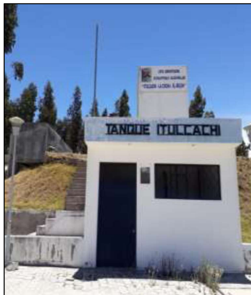
Figura 21 Tanque Cloración La Cocha - Itulachi
