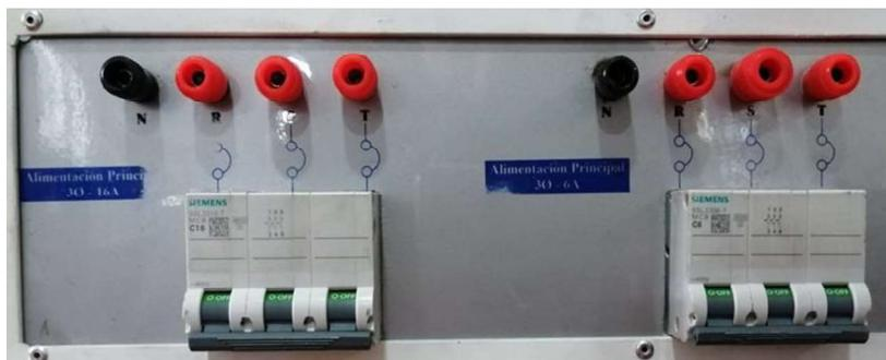
Figura 5. Alimentación 127 y 220 ( $V_{AC}$ ) del Laboratorio de Tecnología Industrial.
