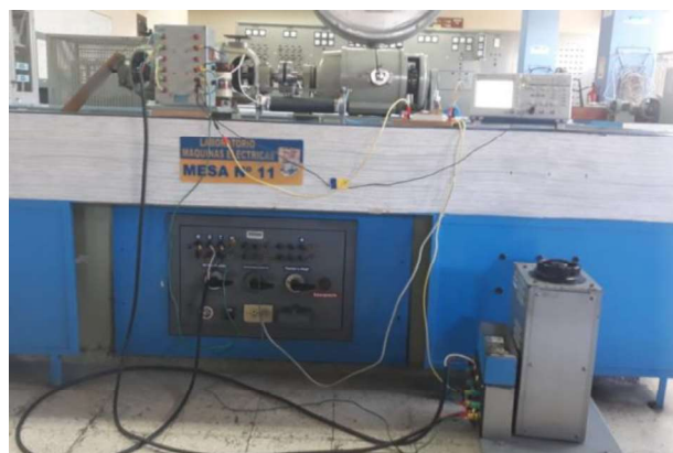
Figura 3.4. Fuente alterna regulable de voltaje para alimentar al transformador bajo prueba.
