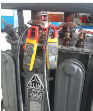
Figura 3.14. Conexión de la fase AB para realizar la falla bifásica a tierra.
