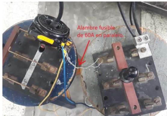
Figura 3.11. Conexión del alambre fusible de 120 [A] como protección ante el evento de cortocircuito.
