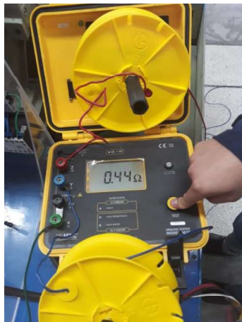
Figura 3.2. Medición de puesta a tierra en Laboratorio de Maquinas Eléctricas-EPN
