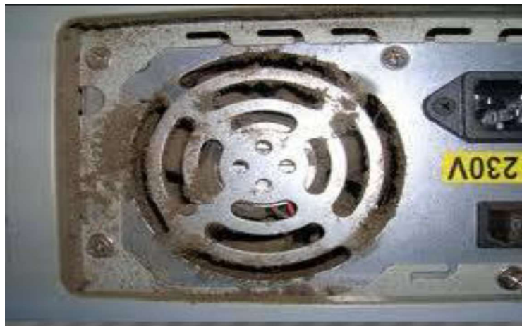
Figura C1.5 Acumulación de polvo en fuente de poder.
