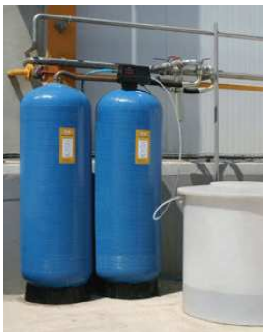
Figura 1.10. Descalcificador instalado
