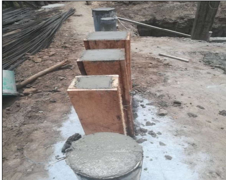
Fotografía No. 3.11: ELABORACION DE PILAS (HORMIGÓN)
