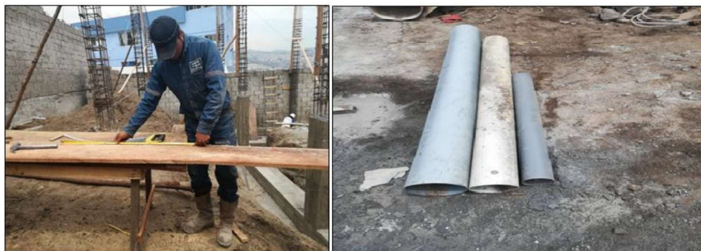
Fotografía No. 3.10: ELABORACION DE PILAS (ENCOFRADO – MADERA - PVC)
