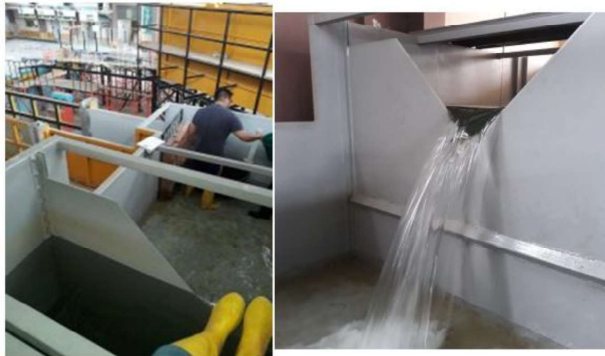
Fotografía No. 3.13: AFORO EN VERTEDERO TRIANGULAR
