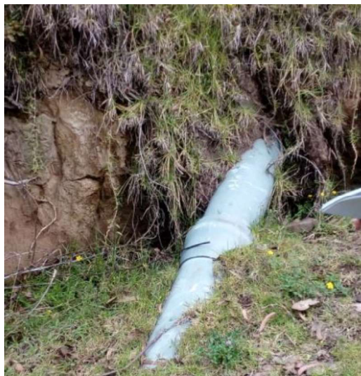
FIGURA 34- TUBERÍA DESCUBIERTA SECTOR MUSHUÑAN.
