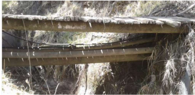
FIGURA 33-TUBERÍA DESCUBIERTA SECTOR LORETO
