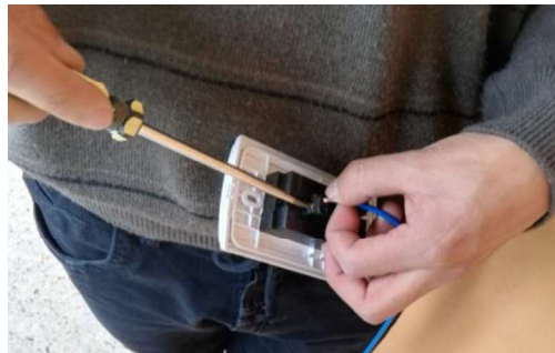
Figura 3.32 Instalación de tomacorriente
