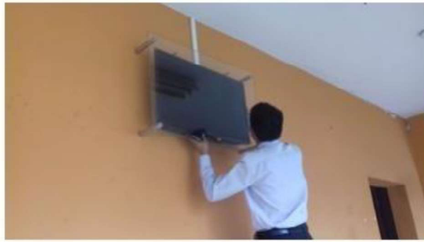
Instalación de los cristales protectores en los soportes metálicos
