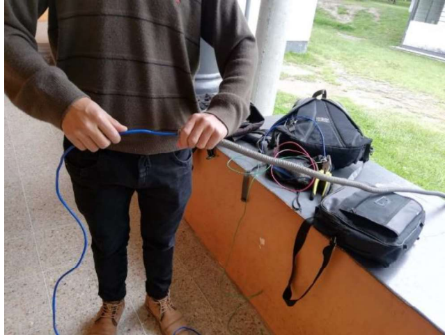
Figura 3.9 Pase de cable UTP por tubería plástica
