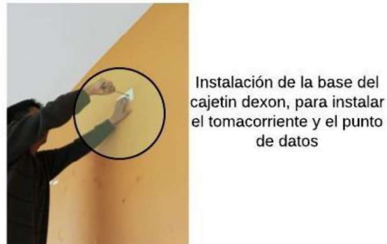
Figura 3.33 Instalación de caja dexon
