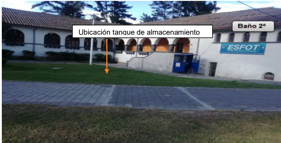
Figura 33 Ubicación para el tanque de almacenamiento
