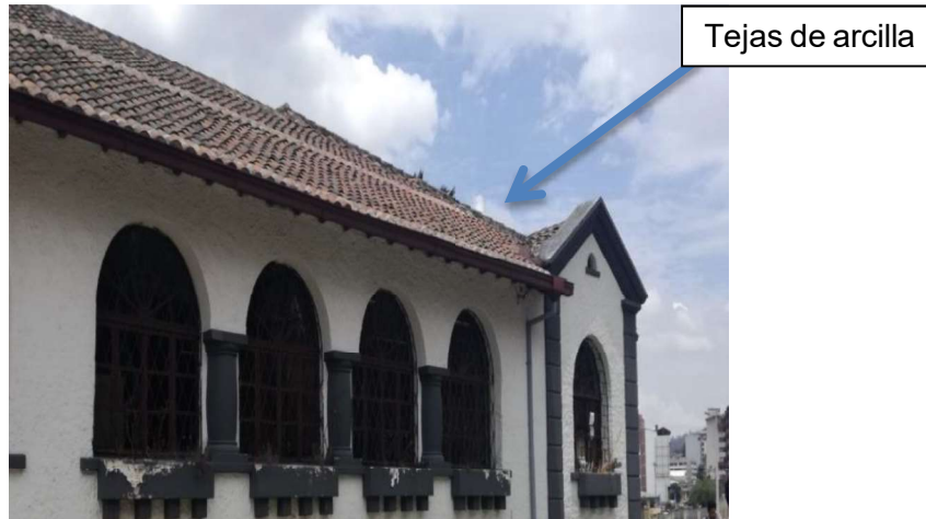
Figura 23 Material del techo
