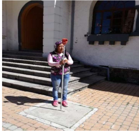
Figura 6 Colocación del prisma en la caja de revisión
