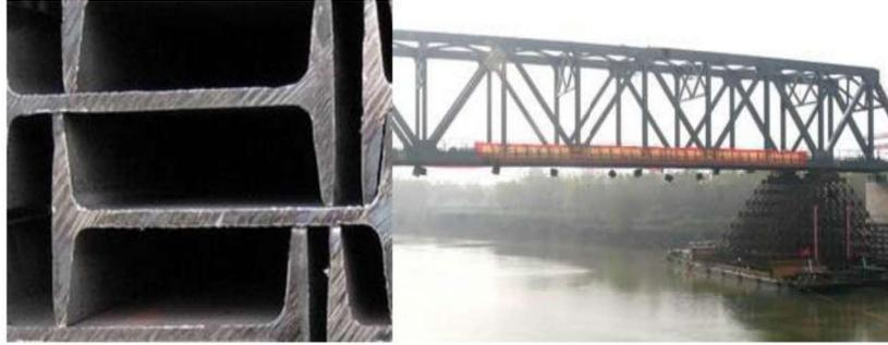
Figura 1.7. Vigas IPN de Acero ASTM A572 Grado 50 para la construcción de puentes.
