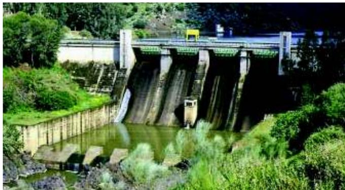
**Figura 2. 3** Presa de Derivación
