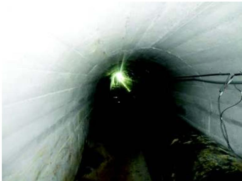
**Figura 2. 17** Galería de hormigón y tubería dentro del cuerpo de la presa
