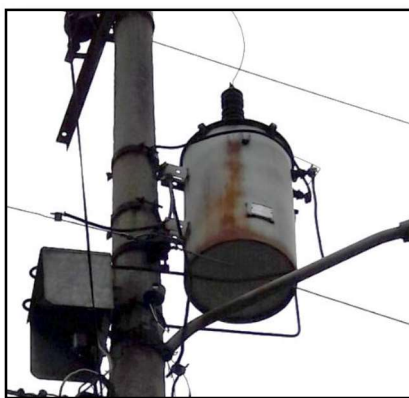
Figura 2.5. Transformador de distribución del Campamento Nueva Vida
