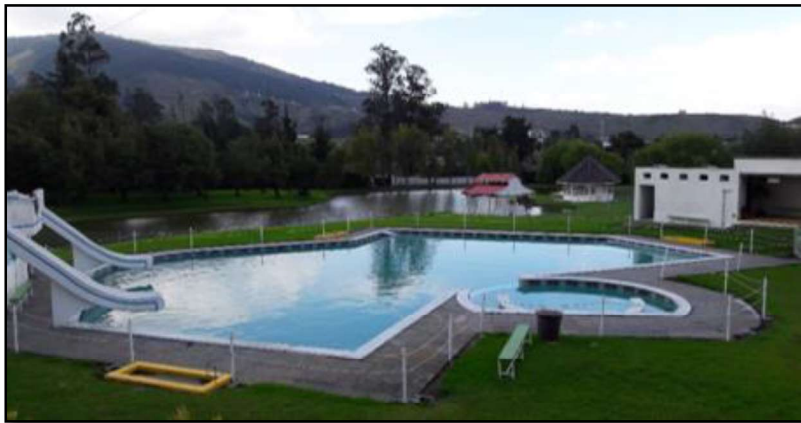
Figura 2.30. Piscina del Campamento Nueva Vida
