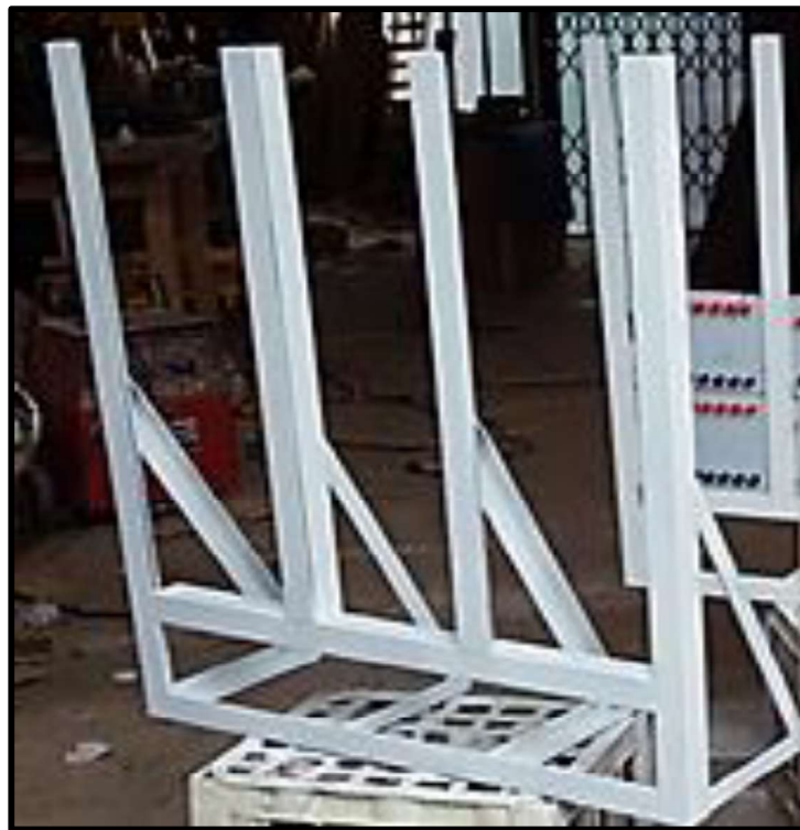
Figura3. 19 Acabado estructura metálica.
