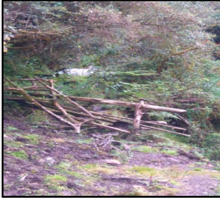
Figura 3.2 Condiciones de ingreso a la captación Fuente: El Autor.
