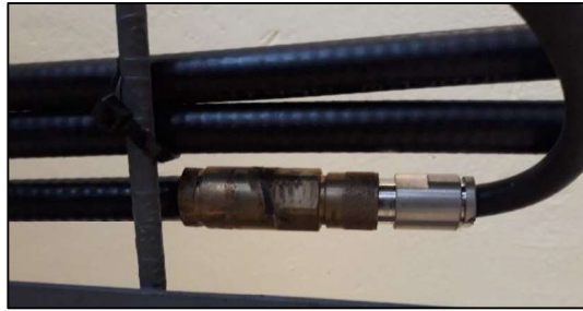
Figura 3.6 Unión de cable Heliax con cable RG8
