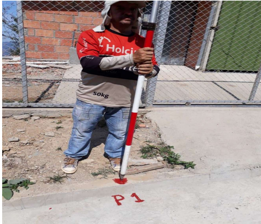
Figura 12. Punto de estación sobre el terreno
