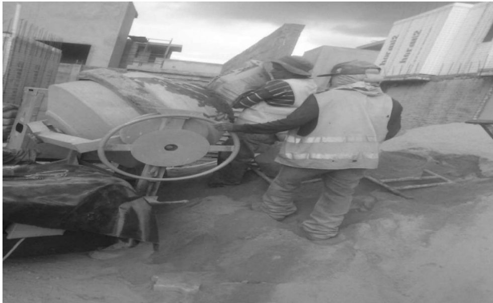
Figura 6. Dosificación de mortero
