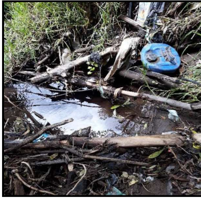
Fotografía 3. Acumulación de basura en el cauce
