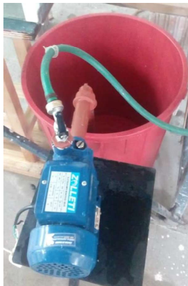
Figura 3.9. Instalación de bomba para sistema de recirculación
