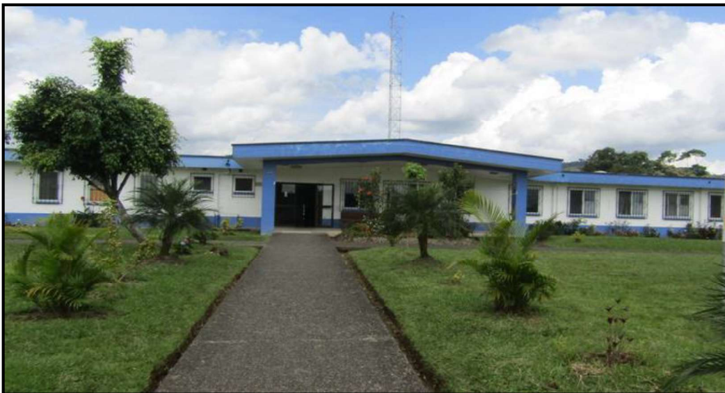
Figura 8. Vista frontal del Hospital Básico del Oriente
