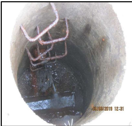
Figura 34. Vista interior del pozo
