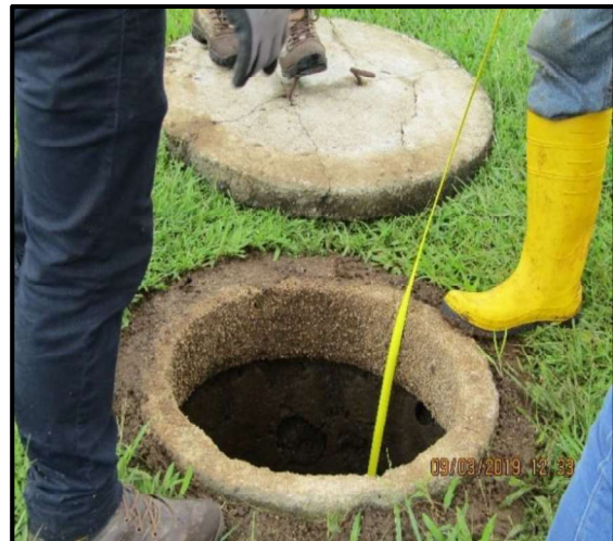
Figura 33. Salida principal del pozo
