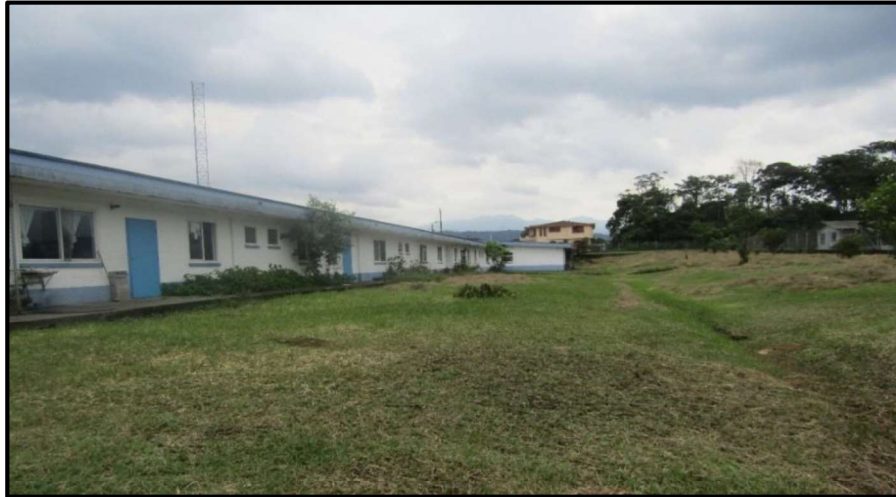
Figura 15. Espacio previsto para la construcción de la PTAR
