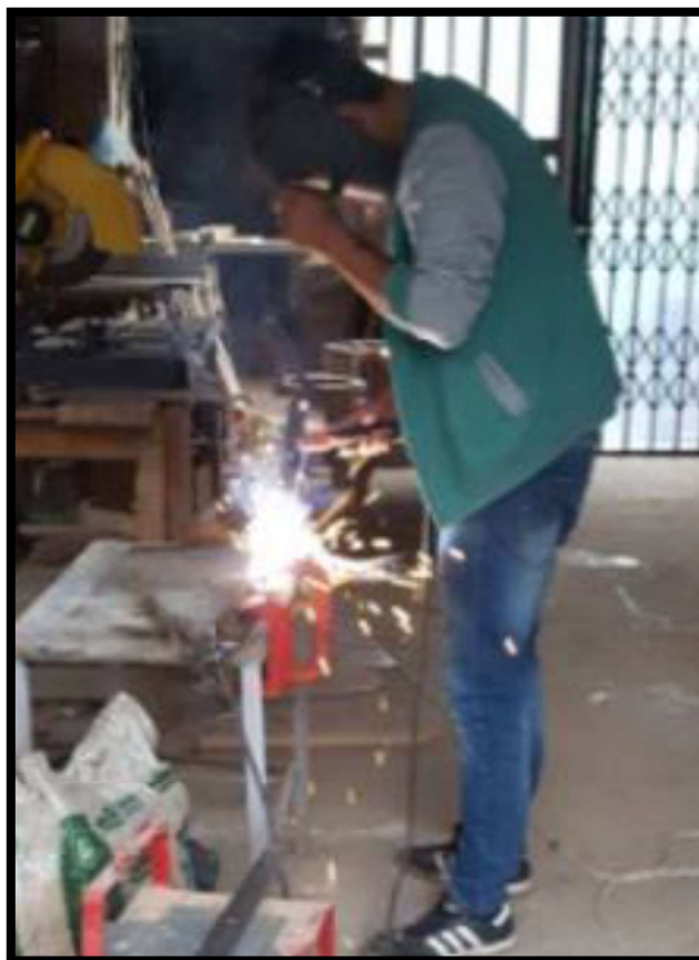
Figura 3.30 Proceso de soldadura de estructura metálica.
