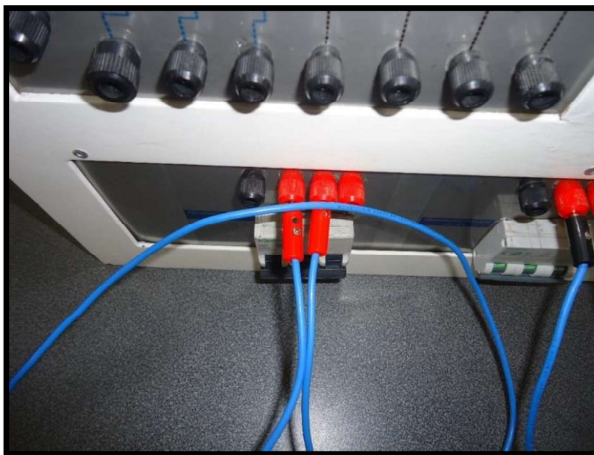
Figura 3.60 Prueba de cortocircuito (Fase - Fase).
