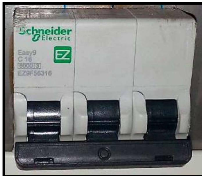
Figura 3.11 Interruptor termomagnético (Circuito de potencia).
