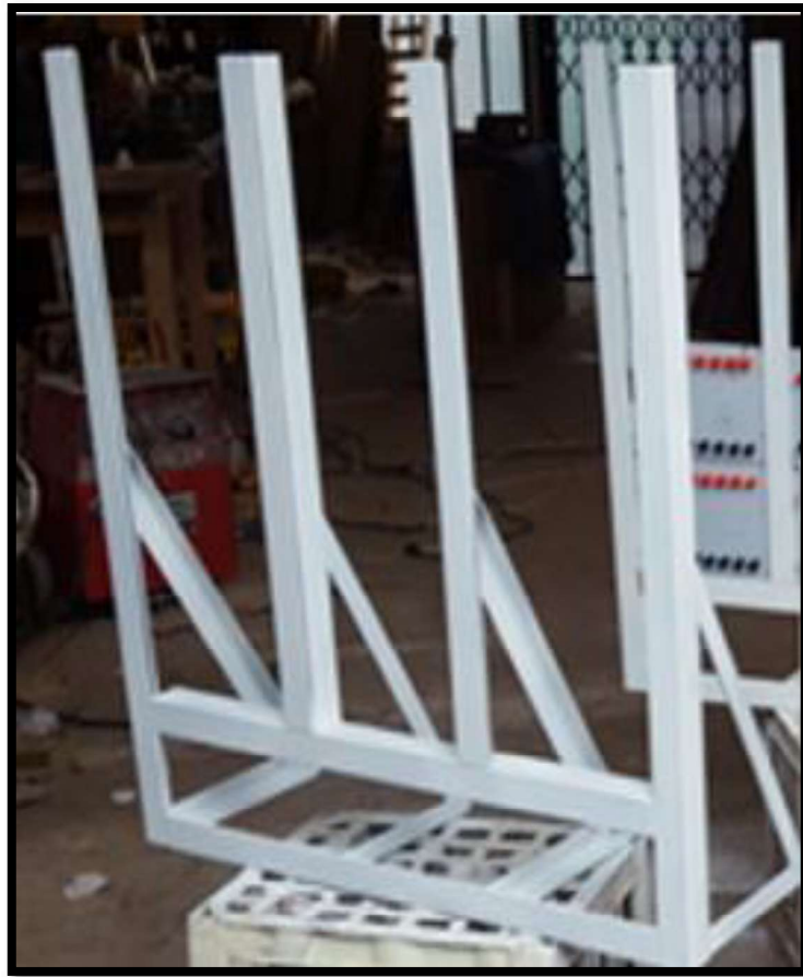
Figura 3.32 Acabado de la estructura metálica.
