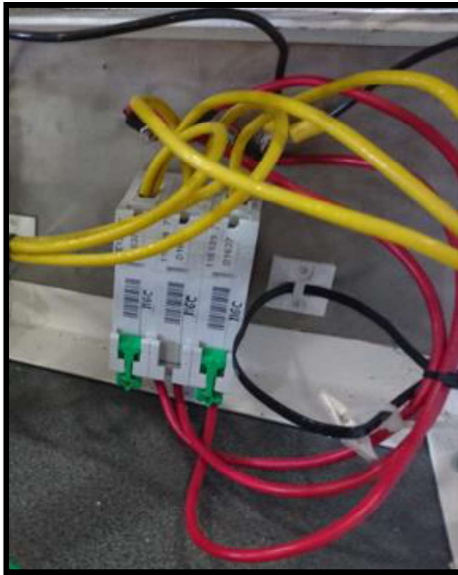
Figura 3.50 Conexión de los termomagnéticos.
