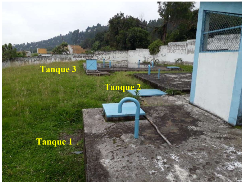
Figura 7. Estación de los tanques de almacenamiento
