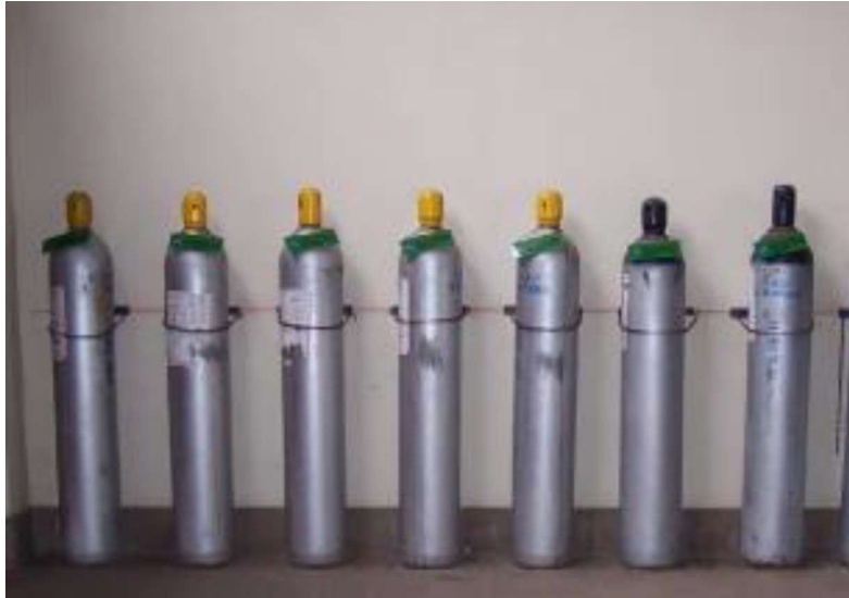
Figura 25. Ejemplo del uso de la cadena en los cilindros
