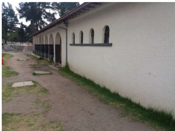
Figura 3.2 Zona 1 (Vista lateral derecha área 1)
