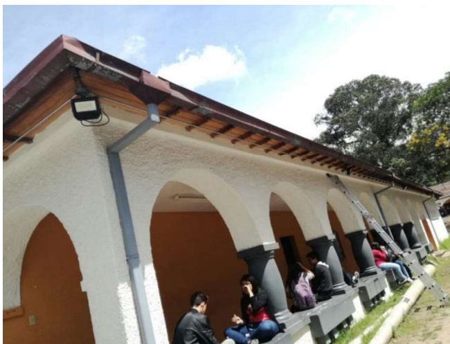
Figura 3.15 Instalación de canaletización.
