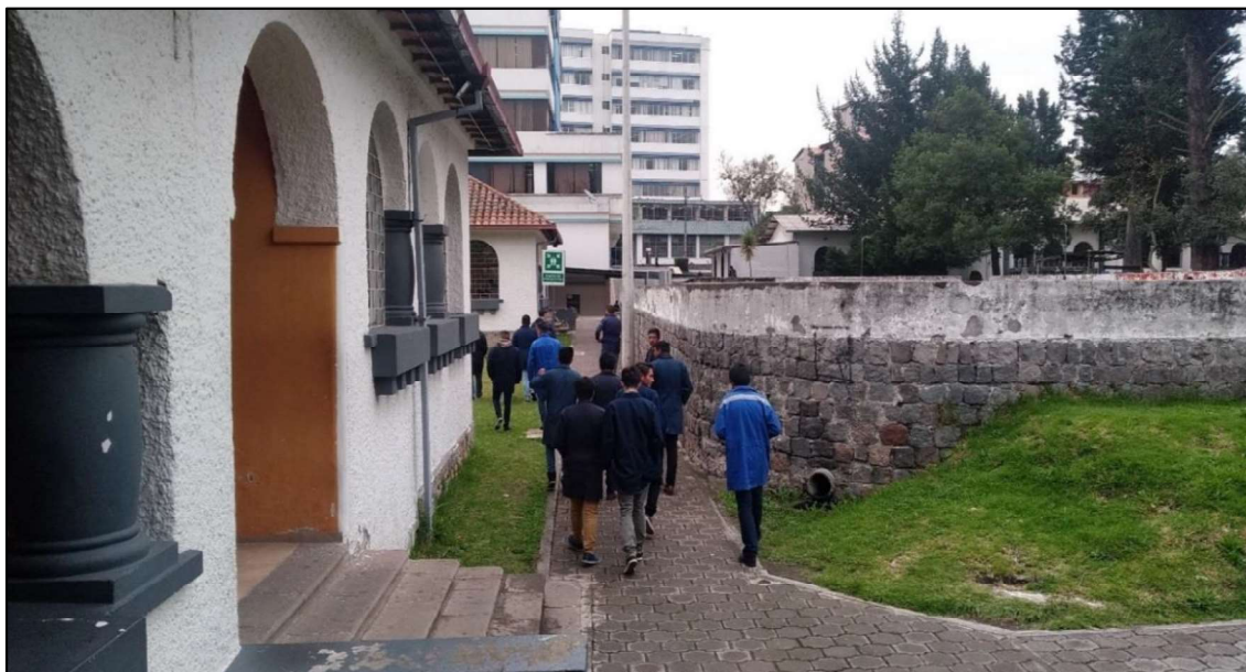
Figura 4.4. Salida de emergencia. (Fuente: Propia)
