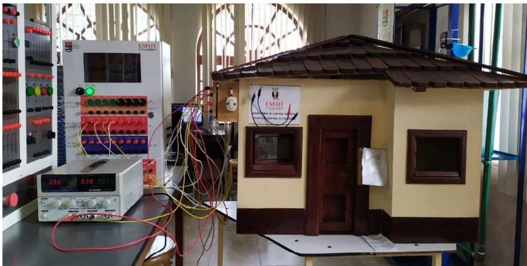
Figura 3.70 Prueba de funcionamiento de la Planta de control de domótica
