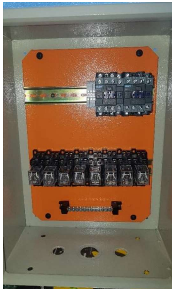
Figura 3. 22 Montaje de elementos de maniobra
