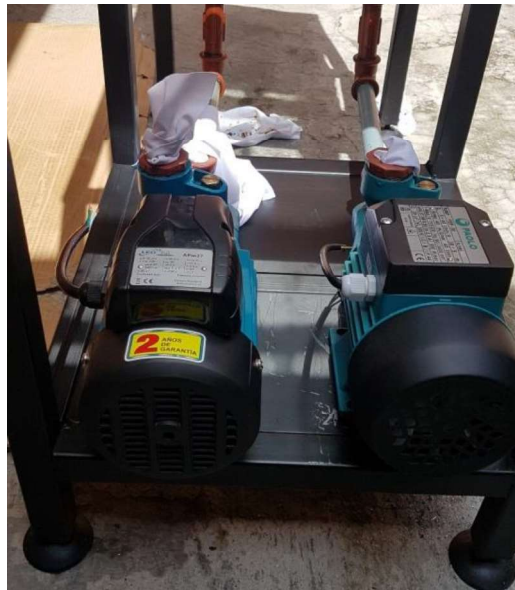
Figura 3. 20 Montaje bombas de agua
