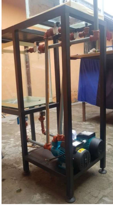
Figura 3. 21 Instalación de las tuberías
