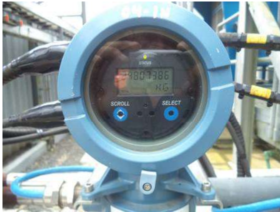
Figura 3.5. Transmisor de caudal másico de combustible de unidades Wartsila W16V32 (Fuente : Departamento Mantenimiento Bloque 18. Petroamazonas)
