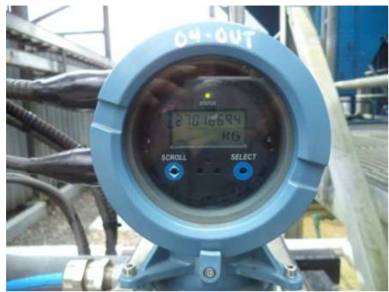
Figura 3.5. Transmisor de caudal másico de combustible de unidades Wartsila W16V32 (Fuente : Departamento Mantenimiento Bloque 18. Petroamazonas)
