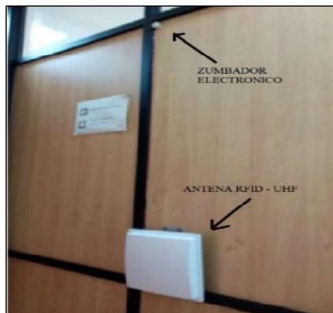
**Figura 3.46 Instalación de antena UHF y zumbador.**
