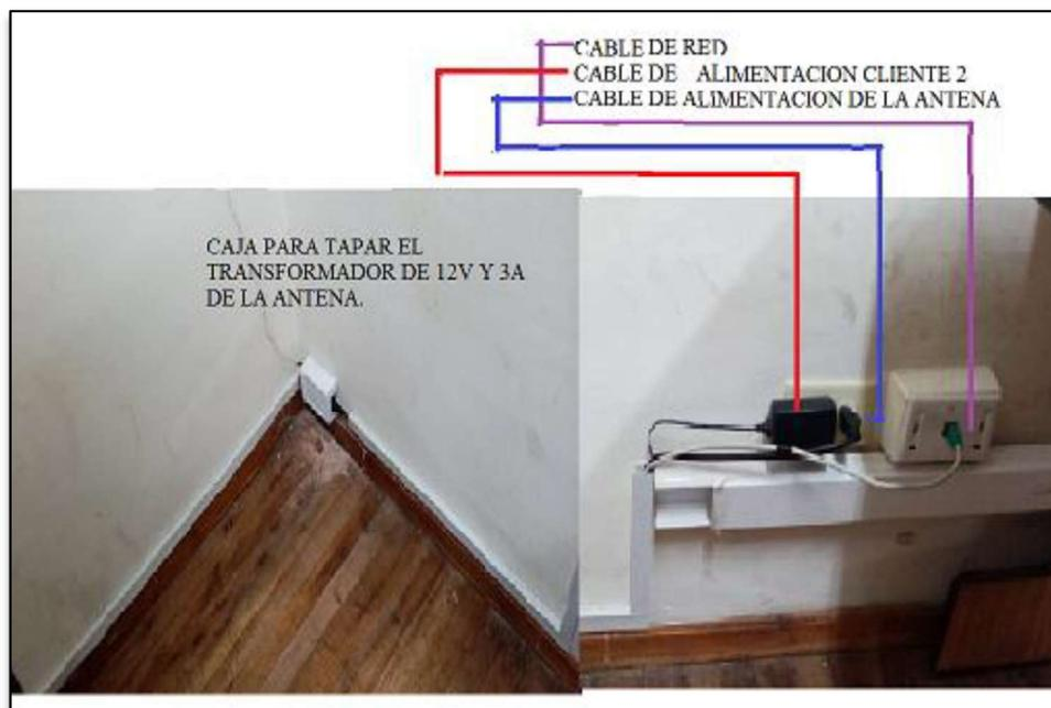
Figura 3.48 Instalación del cableado del cliente 2.
